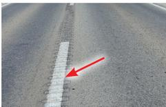
**Guías sonoras longitudinales:** consisten en pequeñas hendiduras en el firme o resalte en la marca vía que al ser pisada por los neumáticos producen una vibración y/o sonido que pretende alertar al conductor de desvíos involuntarios de la trayectoria del vehículo.
